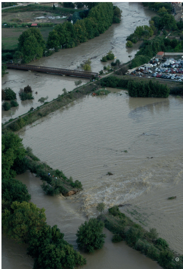
Brèche au niveau du cimetière de Marsillargues – Sept 2002
