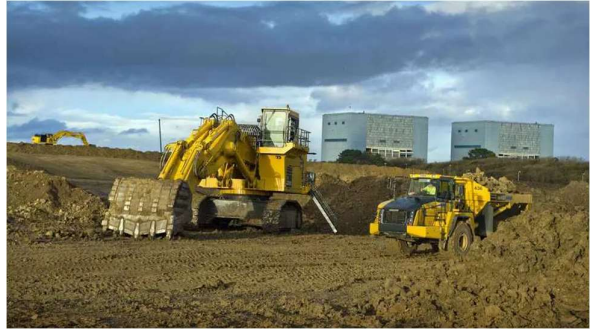
Travaux préparatoires Hinkley Point C © EDF
