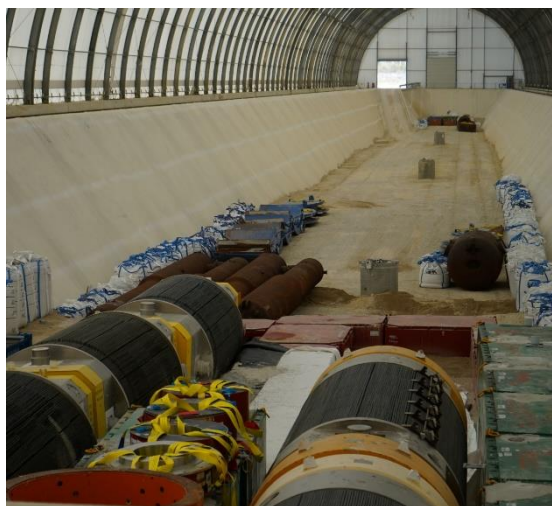
Stockage de déchets volumineux dans une alvéole du Cires
