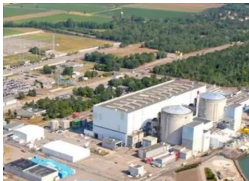
Vue aérienne de la centrale de Fessenheim, dans le Haut-Rhin. (EDF)
