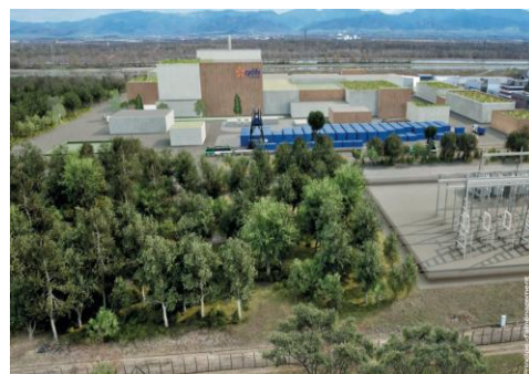
Illustration du Technocentre issue du dossier du maître d'ouvrage
