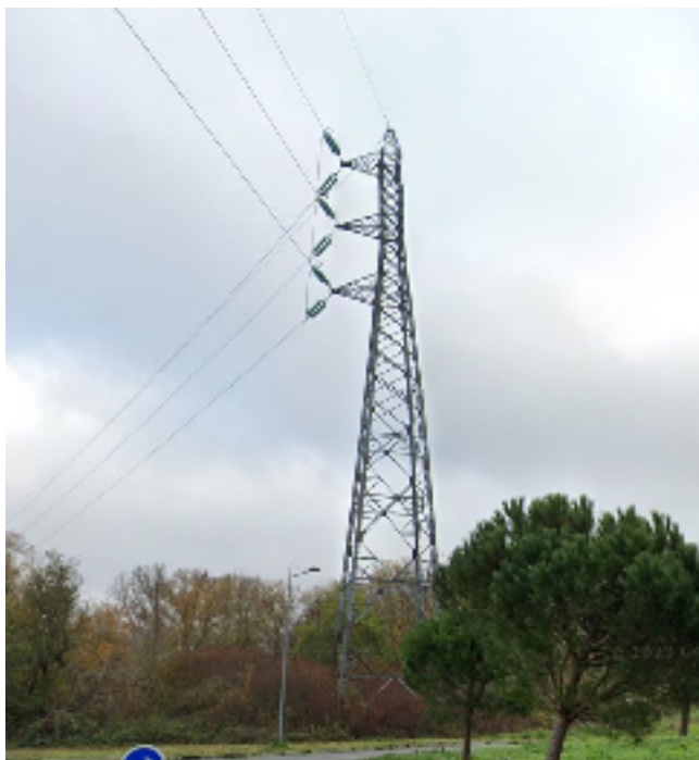
Figure 26 - Pylône avec une seule liaison
