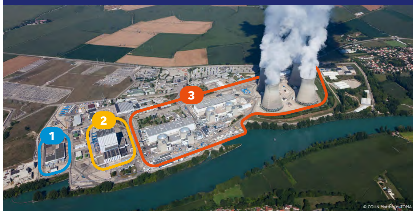
Figure 12. Principaux ouvrages sur le site de Bugey
