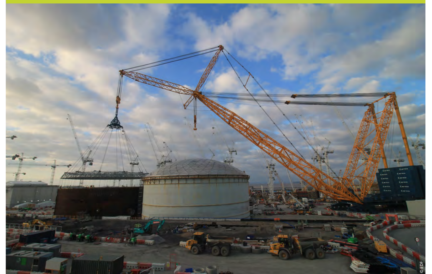
Figure 33. Pose du dôme sur l'unité 2 des EPR d'Hinkley Point
