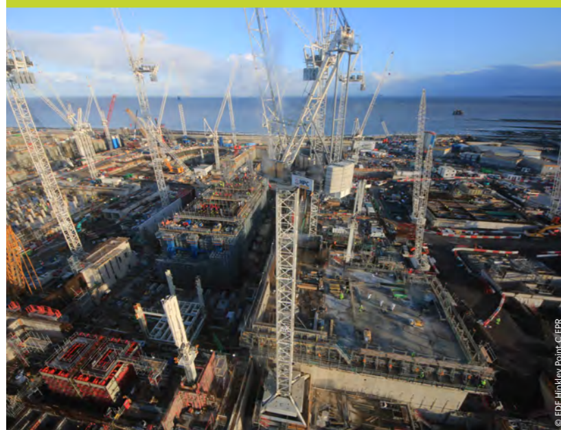
Figure 31. Construction des bâtiments des salles des machines, réacteurs EPR de Hinkley Point C
