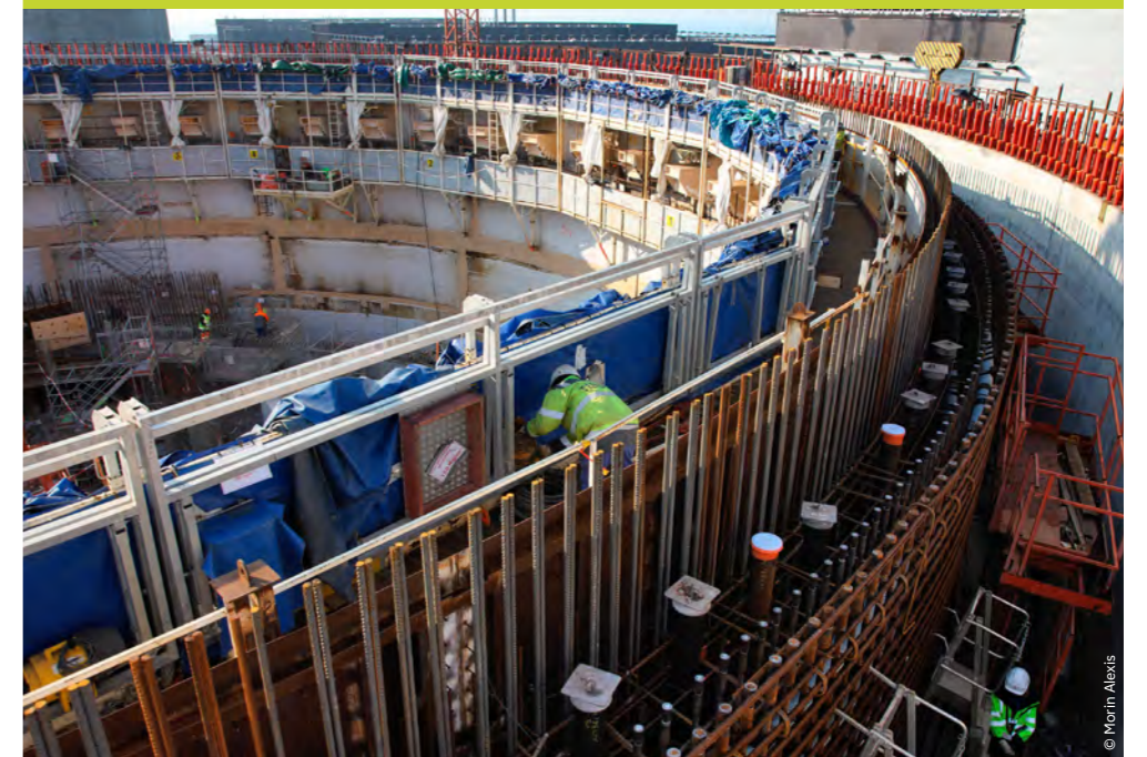
Figure 32. Suivi de chantier EPR de Flamanville 3
