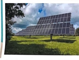
Installer plus de panneaux solaires
