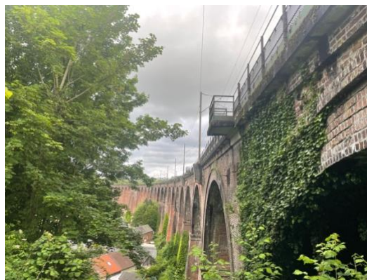
Le viaduc de Barentin, vu de la gare
