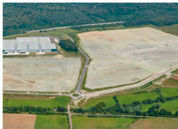
La plateforme a été terrassée en 2011 et en 2020 pour l'accueil de projets qui n'ont finalement pas été réalisés
