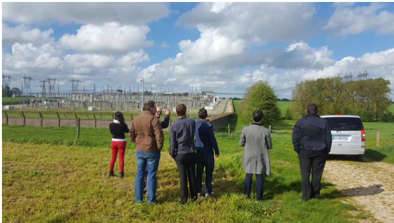
Aperçu de la station RTE de Barnabos. Déplacement sur le terrain le 25 avril 2018
