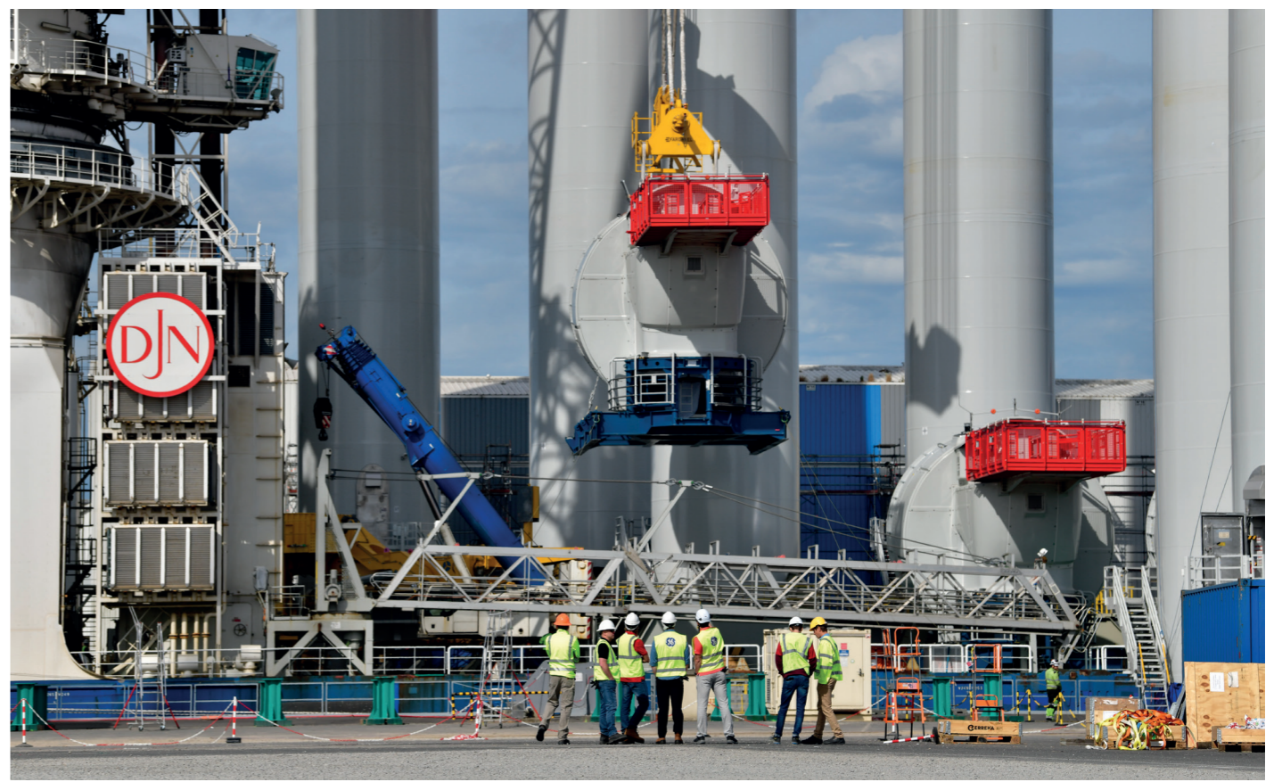
Pré-assemblage des éoliennes posées du parc éolien en mer de Saint-Nazaire.
