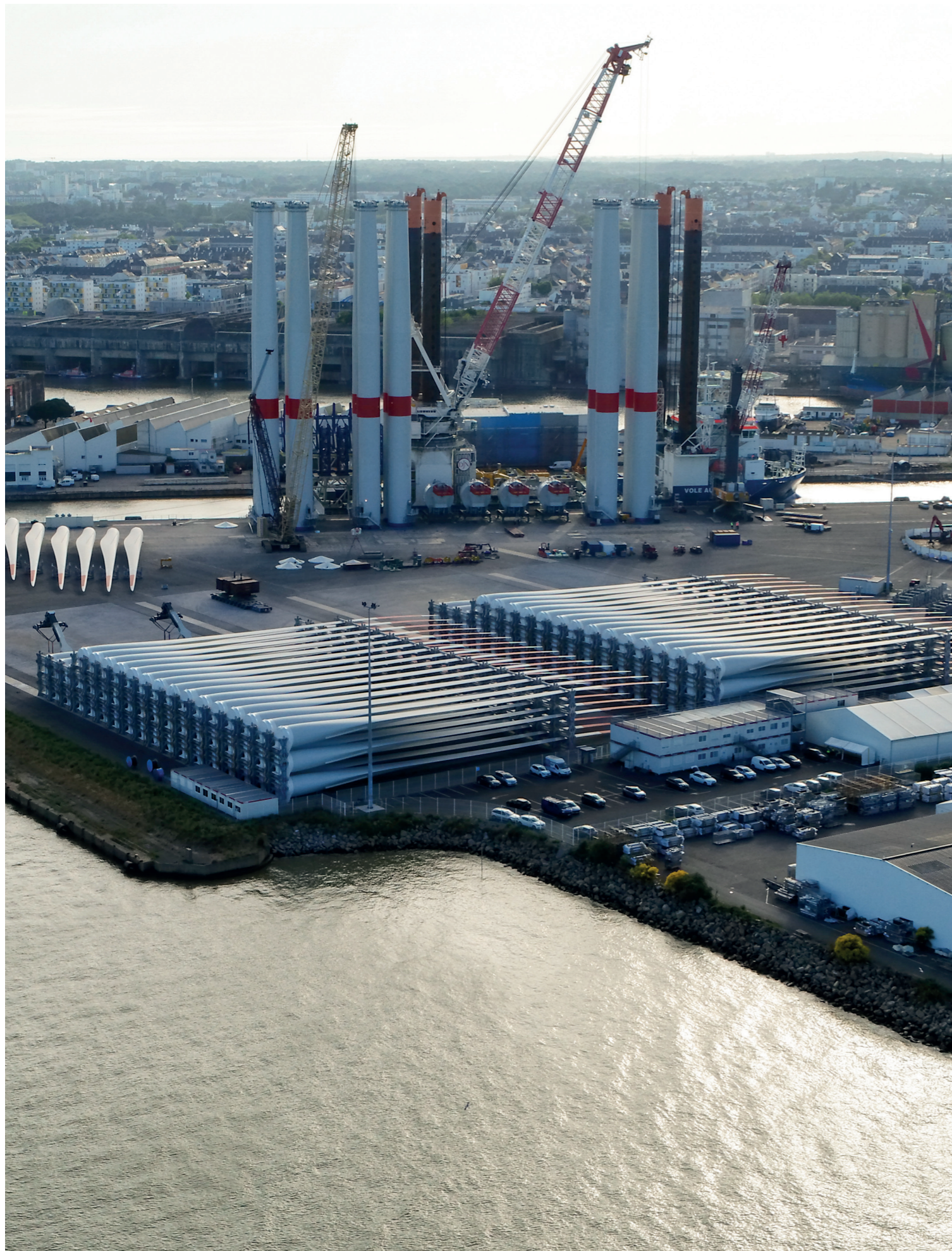
Pré-assemblage des éoliennes posées du parc éolien en mer de Saint-Nazaire.
