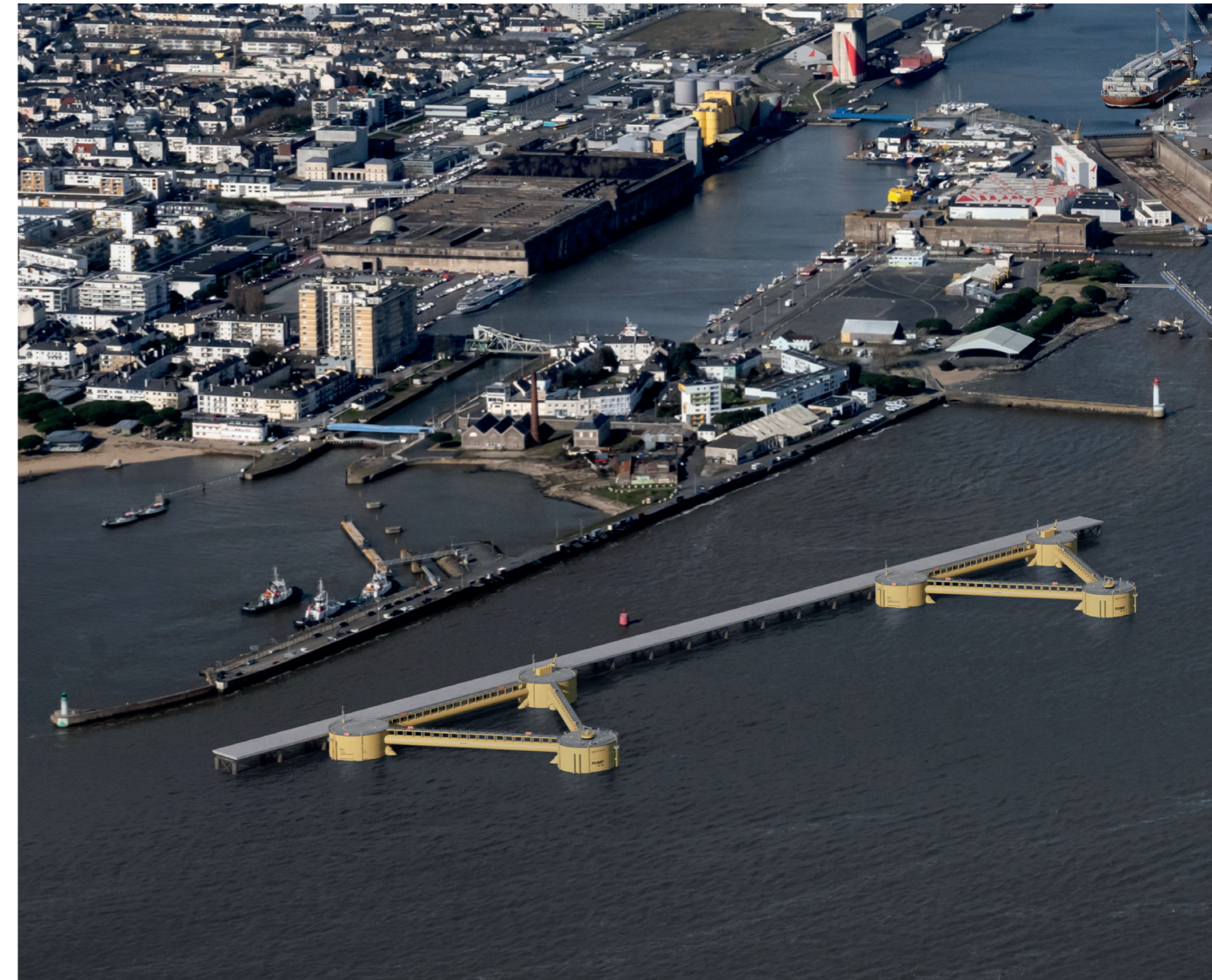
Image de synthèse de l'ouvrage « Ouest » de stockage sur plan d'eau avec deux flotteurs. Document non contractuel. © NSNP – Jacques Rouzeval (perspective) – Franck Badaire (photo).
