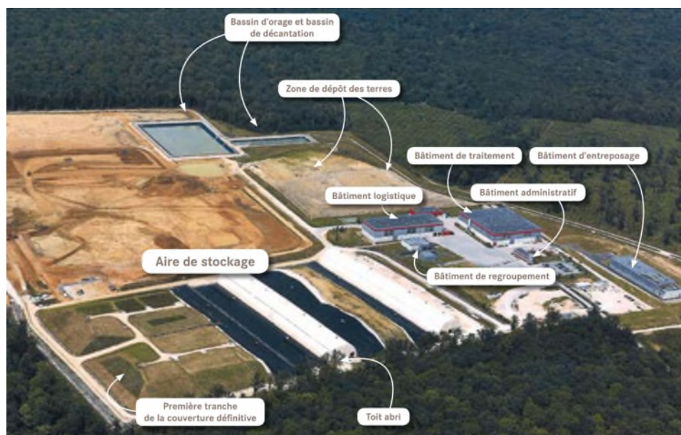
Vue aérienne du Cires (Source Andra)
