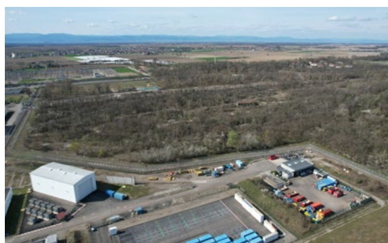
Vue de la parcelle envisagée pour le projet Technocentre en mars 2024 © EDF
