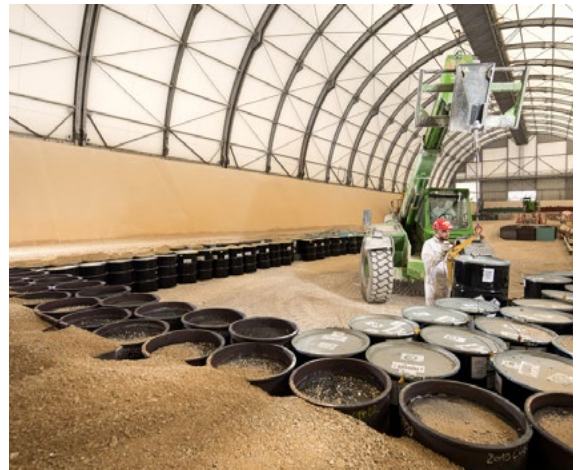
Alvéole en cours de remplissage au Cires © Adrien Daste – Andra
