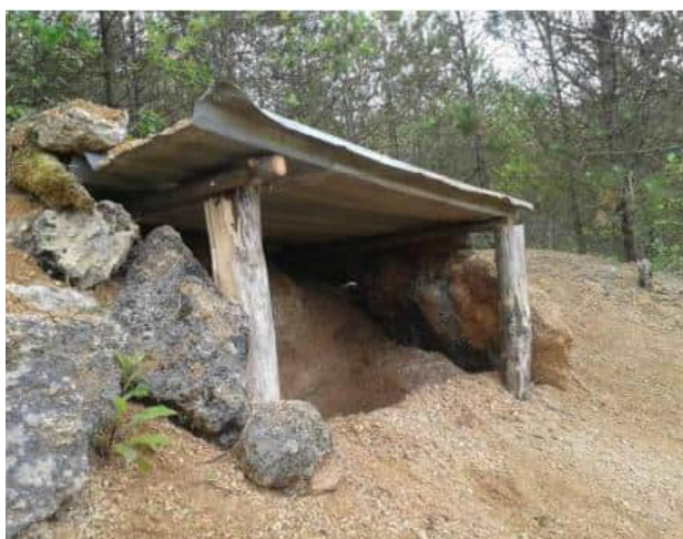
Exemple d'aménagement d'un gîte à Grand-duc sur le haut d'un front de taille. Ce type d'aménagement peut également être réalisé sur une banquette, de préférence peu accessible aux prédateurs. Photo : ©LorraineAssociationNature
