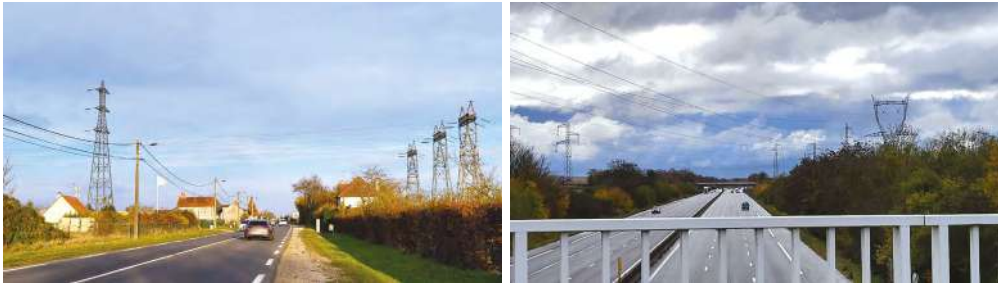
Figure 32 : Route départementale RD2152 à Chaingy (gauche) et autoroute A10 à Poupry (droite) (RTE, 2023)
