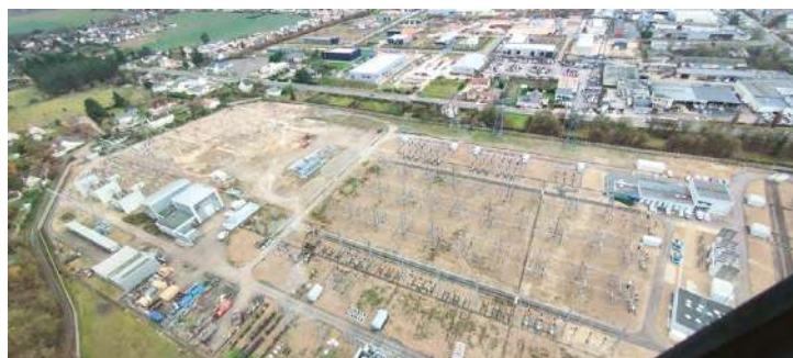
Figure 35 : Vue aérienne du poste existant de CHAINGY (RTE, 2023)
