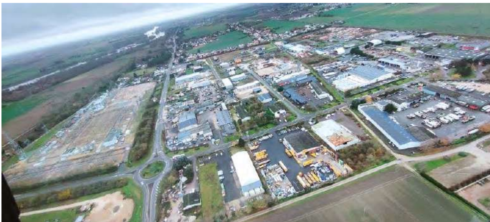
Figure 27 : Vue aérienne sur la zone industrielle de Chaingy (RTE, 2023)
