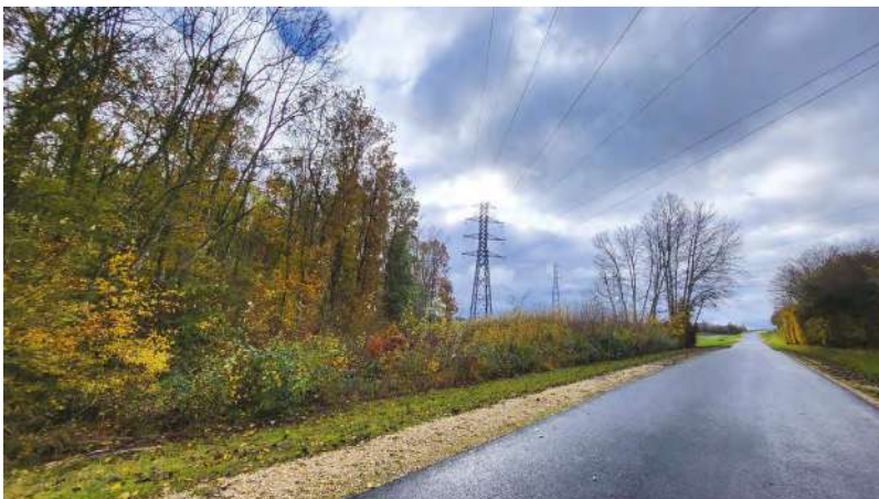
Figure 23 : Arbres protégés à Chaingy (haut) et espaces boisés classés à Poupry (bas) (RTE, 2023)
