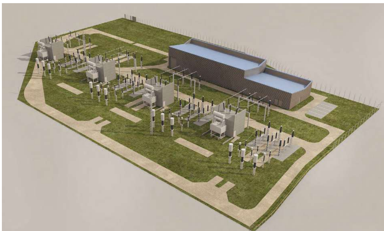
Figure 11 : Exemple d'installation de compensation d'énergie réactive* (source RTE)
