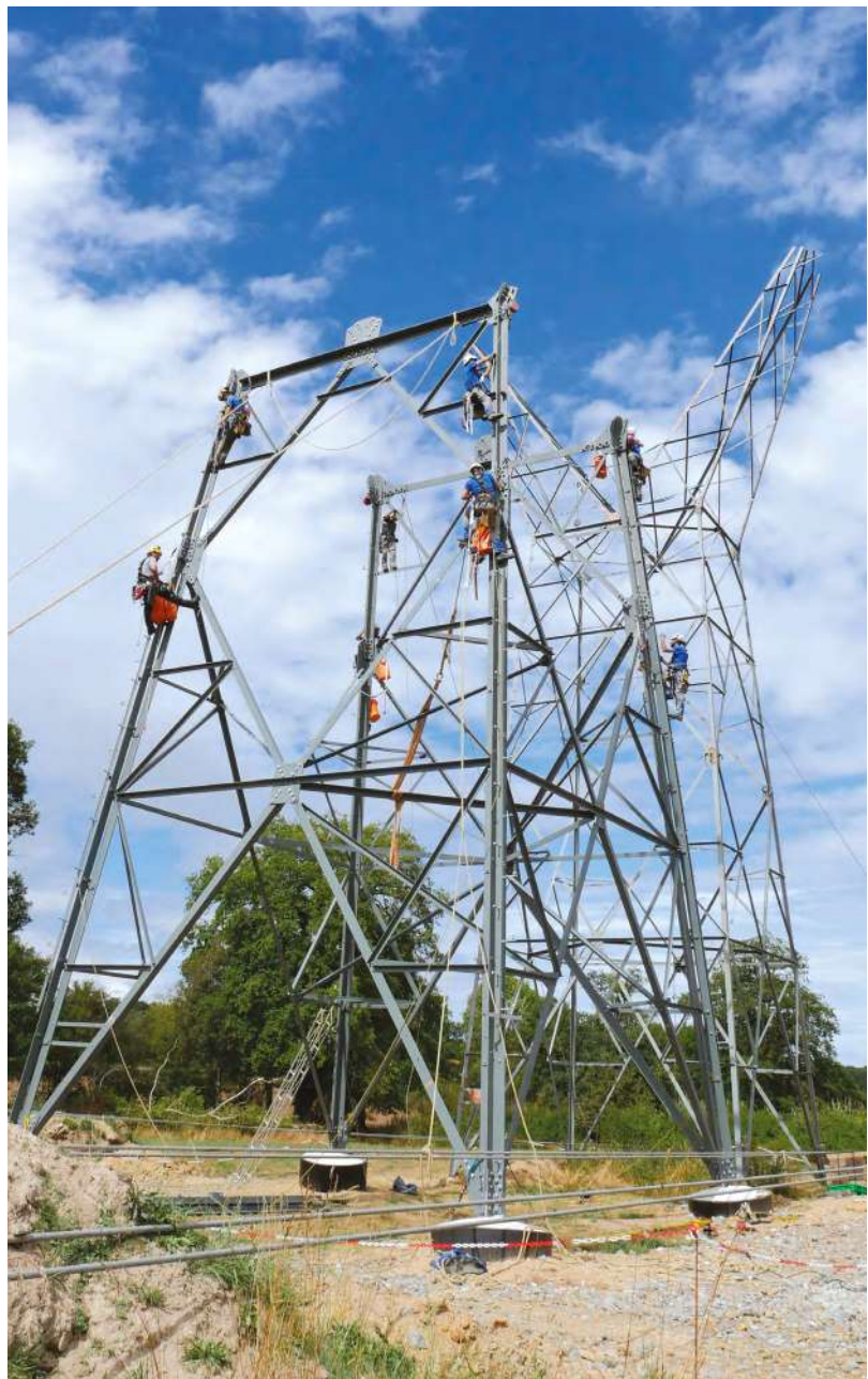
Figure 49 : Travaux réalisés par RTE pour la construction d'un pylône (RTE, 2023)
