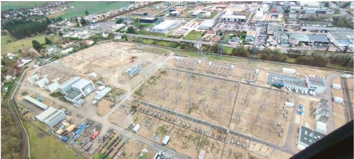
Figure 8 : Vue aérienne du poste existant de CHAINGY (RTE, 2023)
