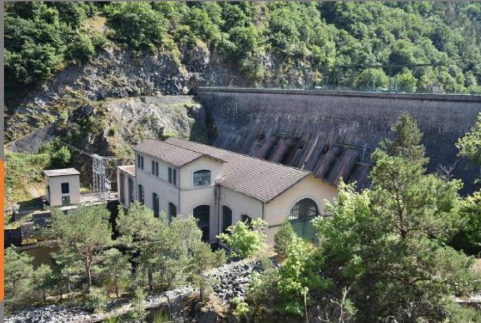
Barrage des Fades Usine de Queuille
