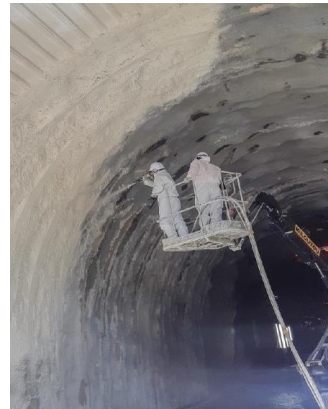
Système d'Étanchéité Projeté Confiné
