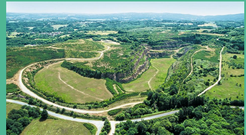
Ancienne mine d'uranium de Bellezane (87) après réhabilitation.
