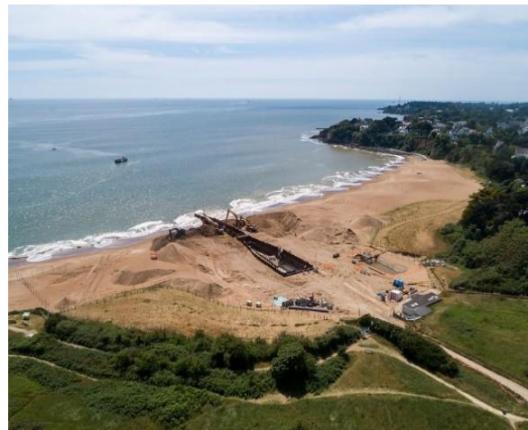
Travaux pour l'atterrage à la Courance (2020)
