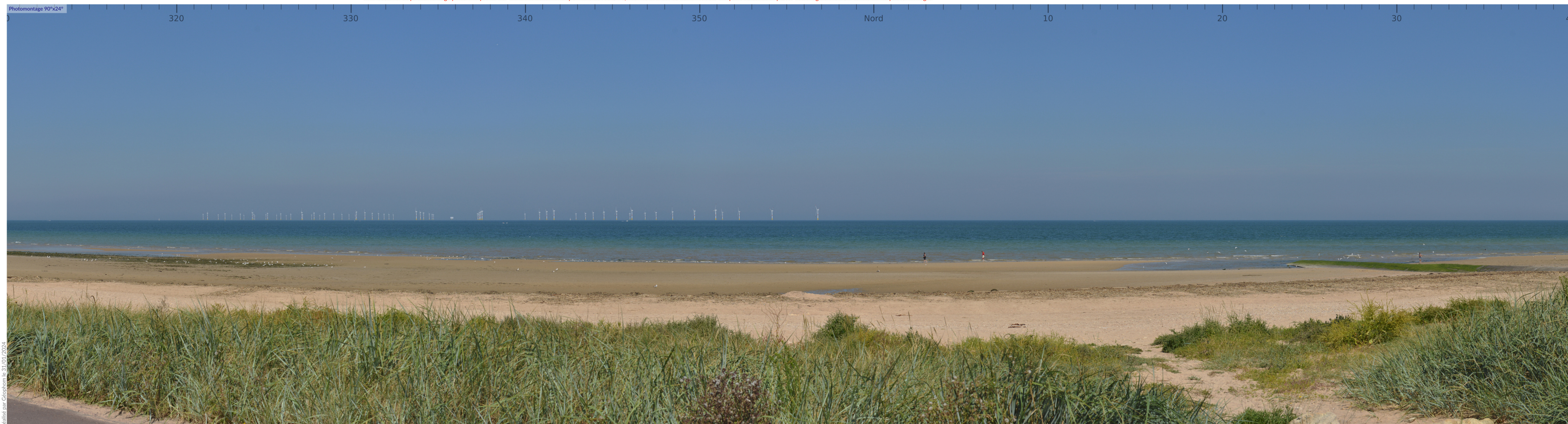
Parc éolien du Calvados
