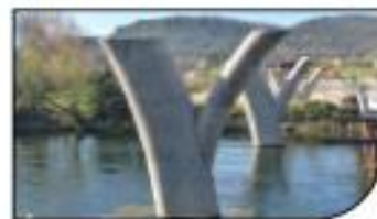
Pile du pont Joséphine Baker
