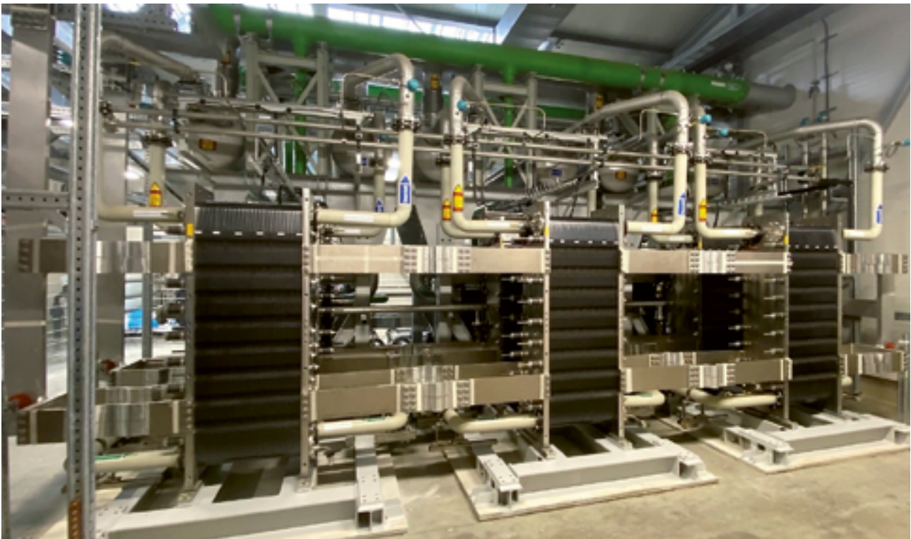
Figure 21 - Électrolyseur PEM de Siemens Energy
