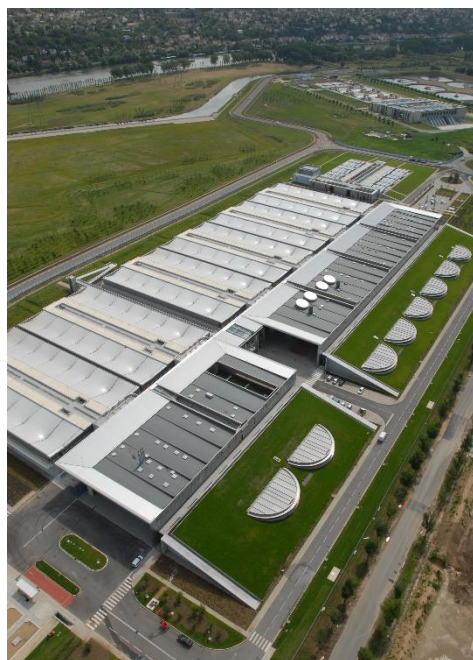
Vue aérienne de l'usine Seine aval du SIAAP © SIAAP
