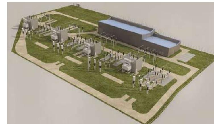
Figure 13 : exemples d'installation de compensation d'énergie réactive (surface : entre 2 et 6 Ha) - (source RTE)
