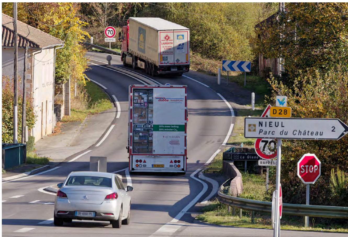
Traversée de la Glane à Nieul
