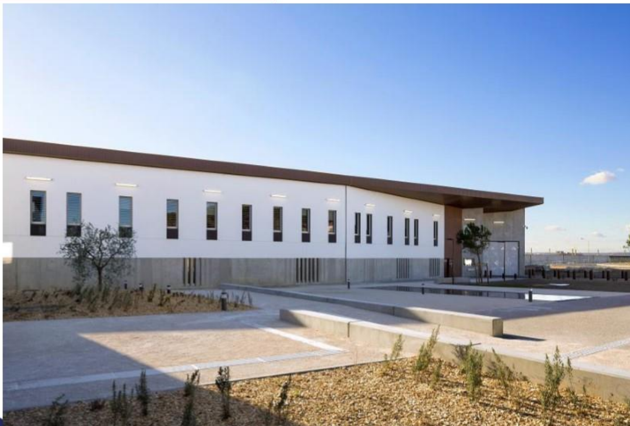
Centre pénitentiaire d'Aix-Luynes 2
