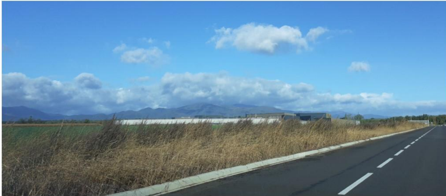
Centre pénitentiaire de Lutterbach
