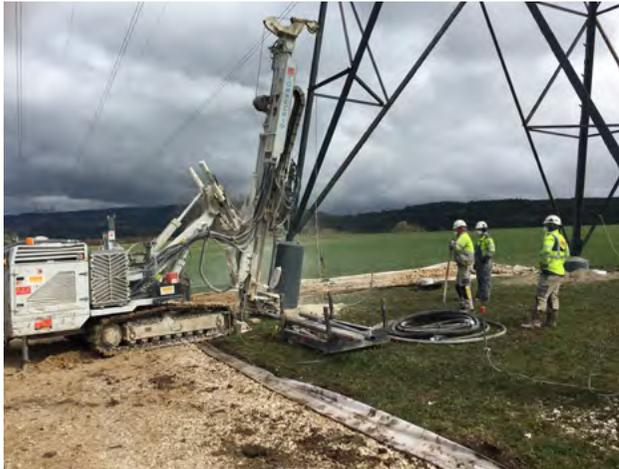
*Renforcement des fondations par la réalisation de micropieux*
