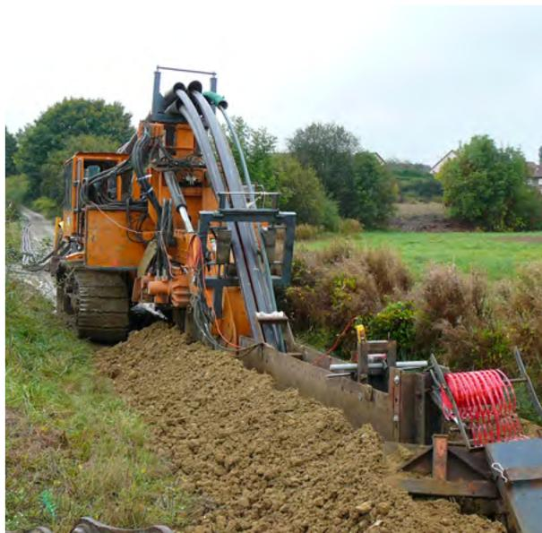
Une fouille d'une profondeur d'environ 1,50 m est réalisée : on y dispose les fourreaux en Polyéthylène, dans lesquels seront déroulés les câbles électriques.
