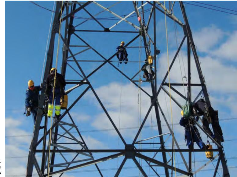
*Renforcement des structures d'un pylône*
